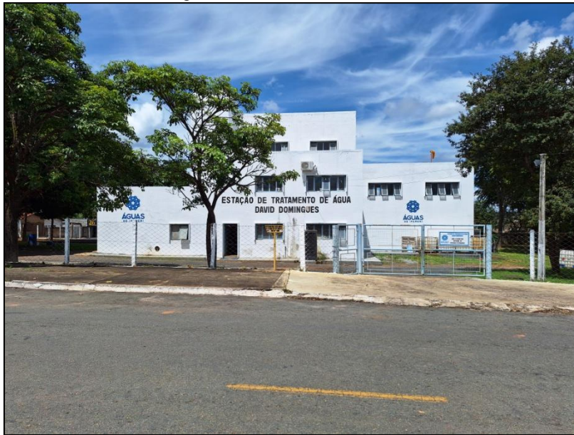
Figura 20: Vista externa da ETA
