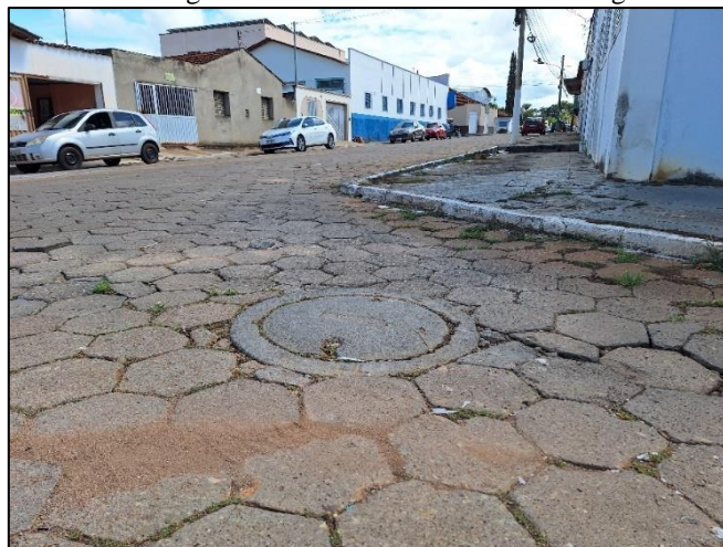
Figura 56: PV de esgoto localizado na Rua Branca de Aguiar Machado
