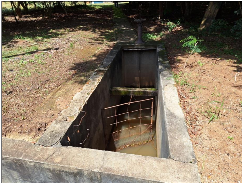
Figura 14: Canal de adução e grade fina. Caixa de areia à jusante
