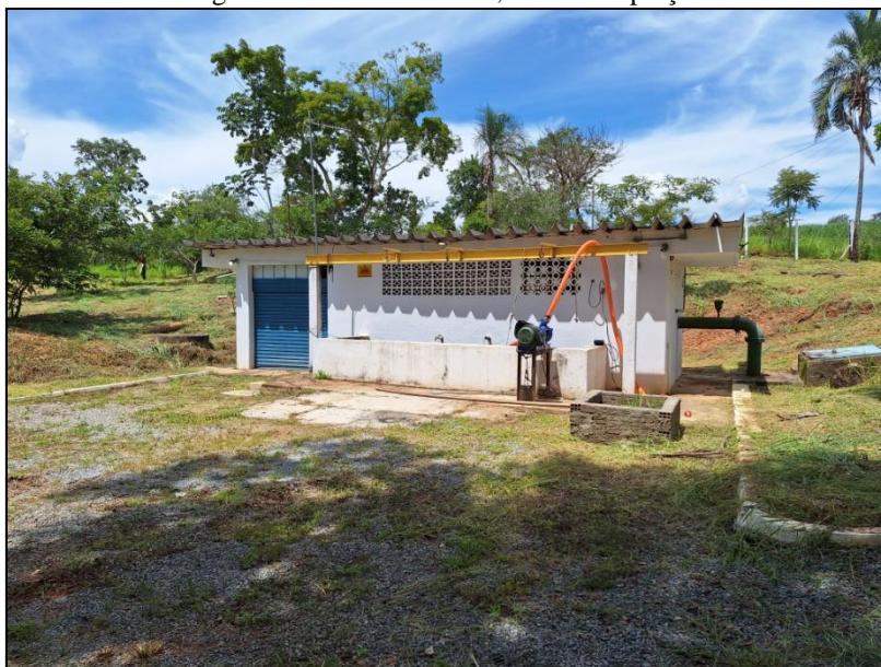
Figura 15: Vista da EEAB, desde a captação
