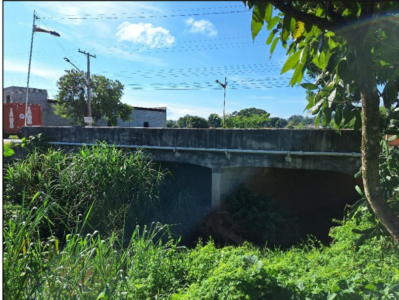
Figura 61: Bueiro celular construído no trecho urbano da Rodovia GO-213
