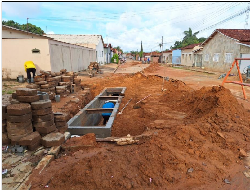
Figura 65: Obras de drenagem pluvial na Rua Reinaldo de Souza Barbosa
