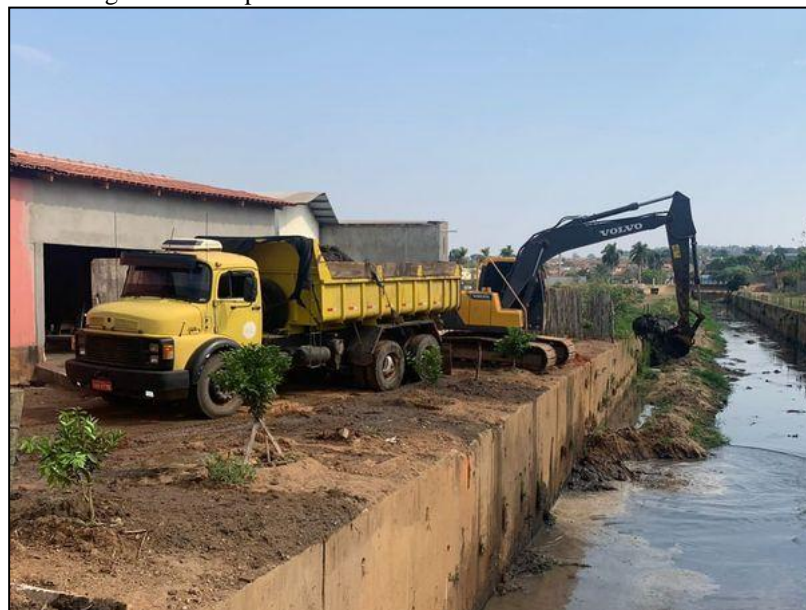
Figura 66: Limpeza e desassoreamento do Ribeirão Vai Vem
