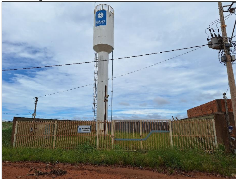
Figura 46: REL metálico 50 m 3 situado no Jardim Fiuza
