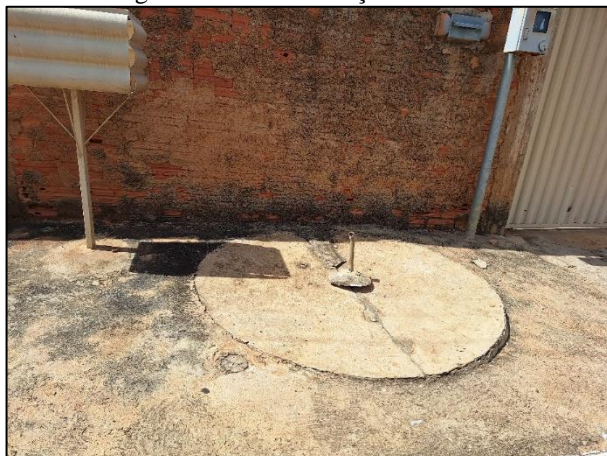
Figura 52: Fossa negra construída na calçada do bairro Silvio Lombardi
