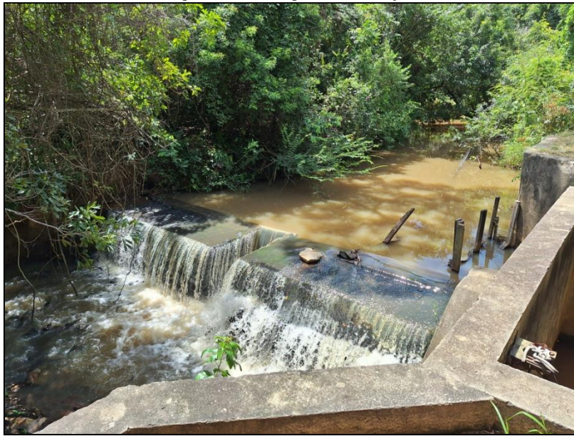
Figura 12: Barragem de elevação
