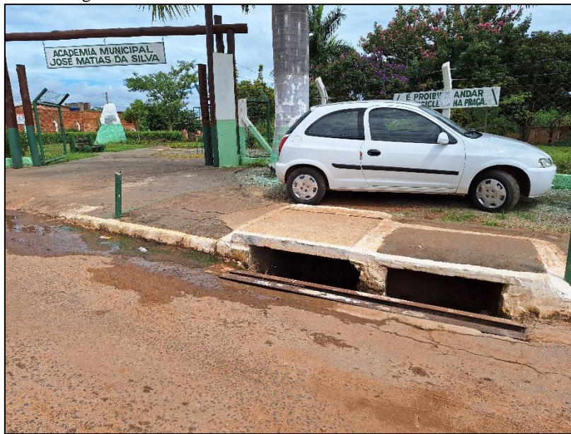
Figura 70: Boca de lobo localizada na Rua José R. Barbosa
