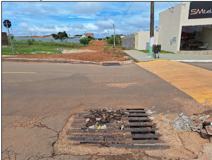
Figura 68: Boca de lobo localizada na Av. Paranaíba
