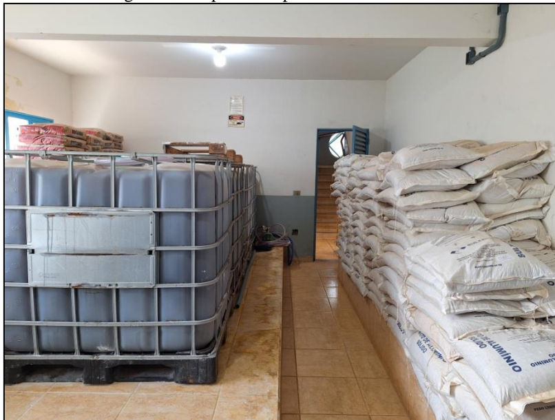
Figura 23: Depósito de policloreto de alumínio
