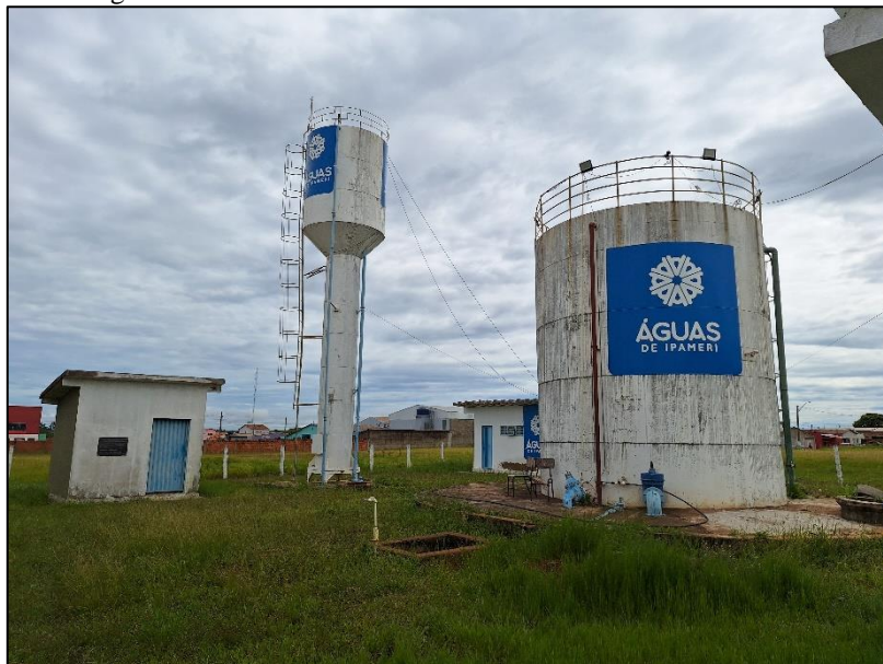
Figura 47: RAP 100 m 3 e REL 30 m 3 situado no Setor Central
