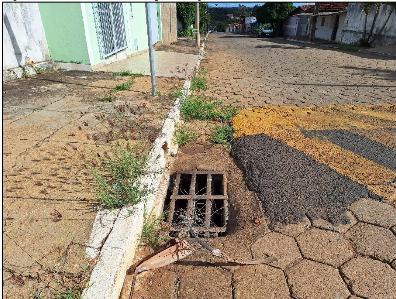
Figura 59: Boca de lobo do tipo com grelha, situada na Av. Estado de Goiás
